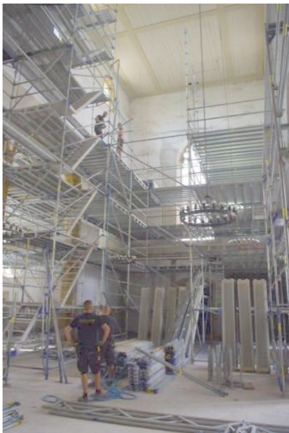
Kirchenschiff eingerüstet
